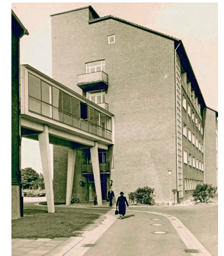
Verbindung vom Krankenhaus zur Krankenpflegeschule
