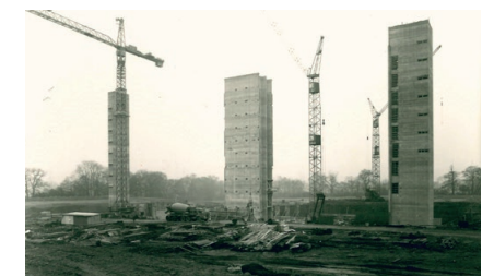
Rohbau des heutigen Gebäudes im Schlosspark (Beginn 1970iger Jahre).
